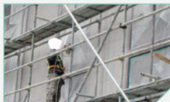
작업발판 단부 안전난간대(2면) 설치
